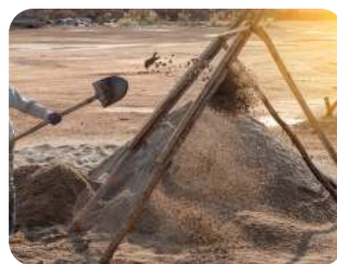
Gambar 5.26 Metode pengayakan yang dilakukan oleh pekerja bangunan.
